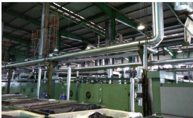
▲圖 10 汽電公司供應中壓蒸汽取代染整業原燃煤之熱媒鍋爐
