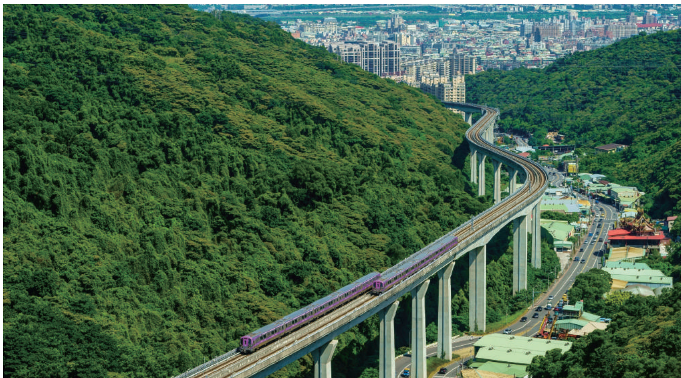
▲圖 34 高橋墩水保區橋梁結構完成情形
