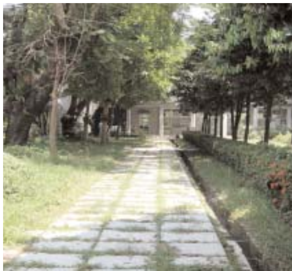
▲ 將水泥鋪面改為透水鋪面，改善視覺效果，並增進水回歸大地的速度 彭厝國小提供
