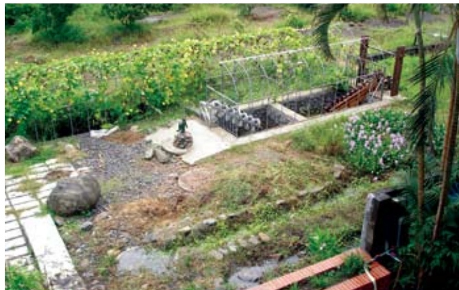
中水經過人工濕地淨化貯存，再經龍骨水車與阿基米得抽水機送至對岸農園澆灌。工業區大排水溝以絲瓜棚架覆蓋，兼具安全、美觀與實用。
